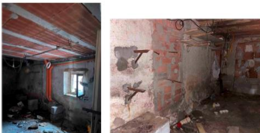
Vista delle murature e della porzione di solaio massivo.
